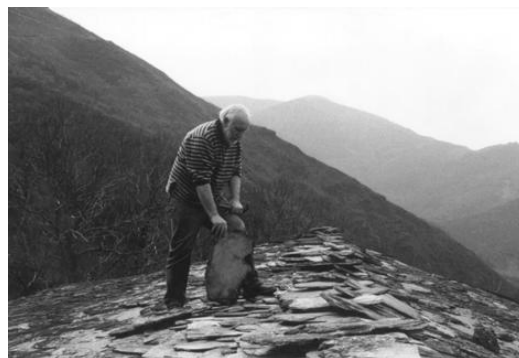
Arranxando o tellado na súa casa do Courel
